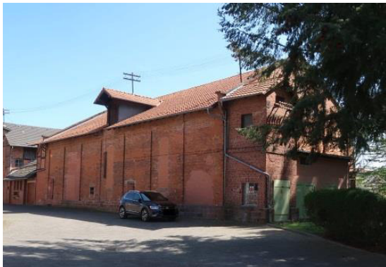
Blick auf den ehemaligen Gär- und Eiskeller (Gebäude A)
