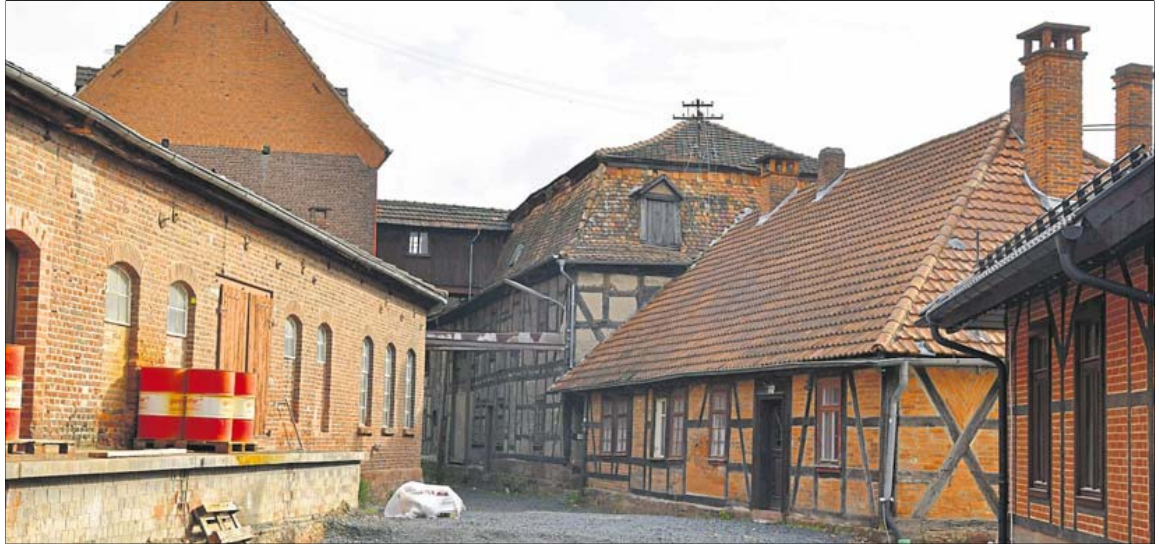
Im hinteren Teil der ehemaligen Brauerei warten noch einige Gebäude auf die Sanierung und eine zukunftsstrahlende Nutzung.
