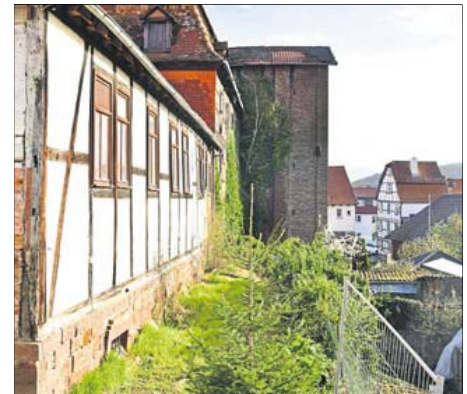
Entlang der Brauereigebäude soll ein Weg zur Innenstadt angelegt werden.
