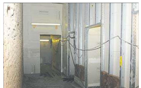
Der Trakt mit den Toiletten und Technikräumen befindet sich im Kellergeschoss.
