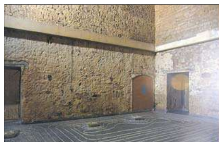
Die Wände im Keller bleiben historisch-rustikal, erhalten aber eine moderne Fußbodenheizung.
