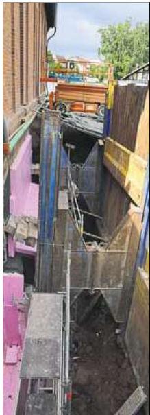
Etlche Meter tief ist die Baugrube für das Anbringen der Dämmung.
