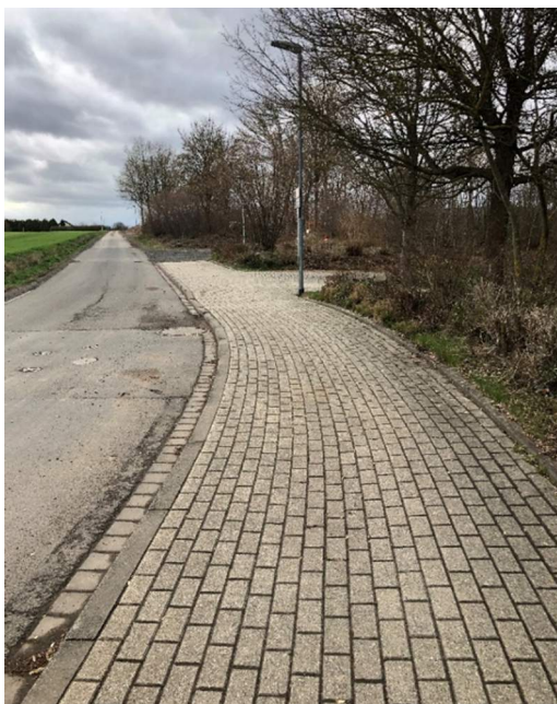
Abbildung 9: Südlicher Änderungsbereich – Schlesische Straße, Zufahrt zum öffentl. Parkplatz.
