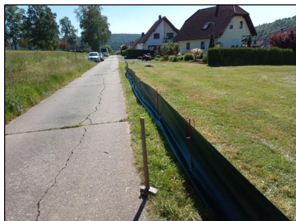
Abb. 19: Reptilienschutzzaun im Bereich des Baufeldes.
