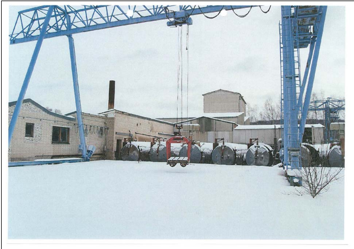
Abb. 7: Bisherige Gebäudekubaturen des ehemaligen Kalksandsteinwerkes)
