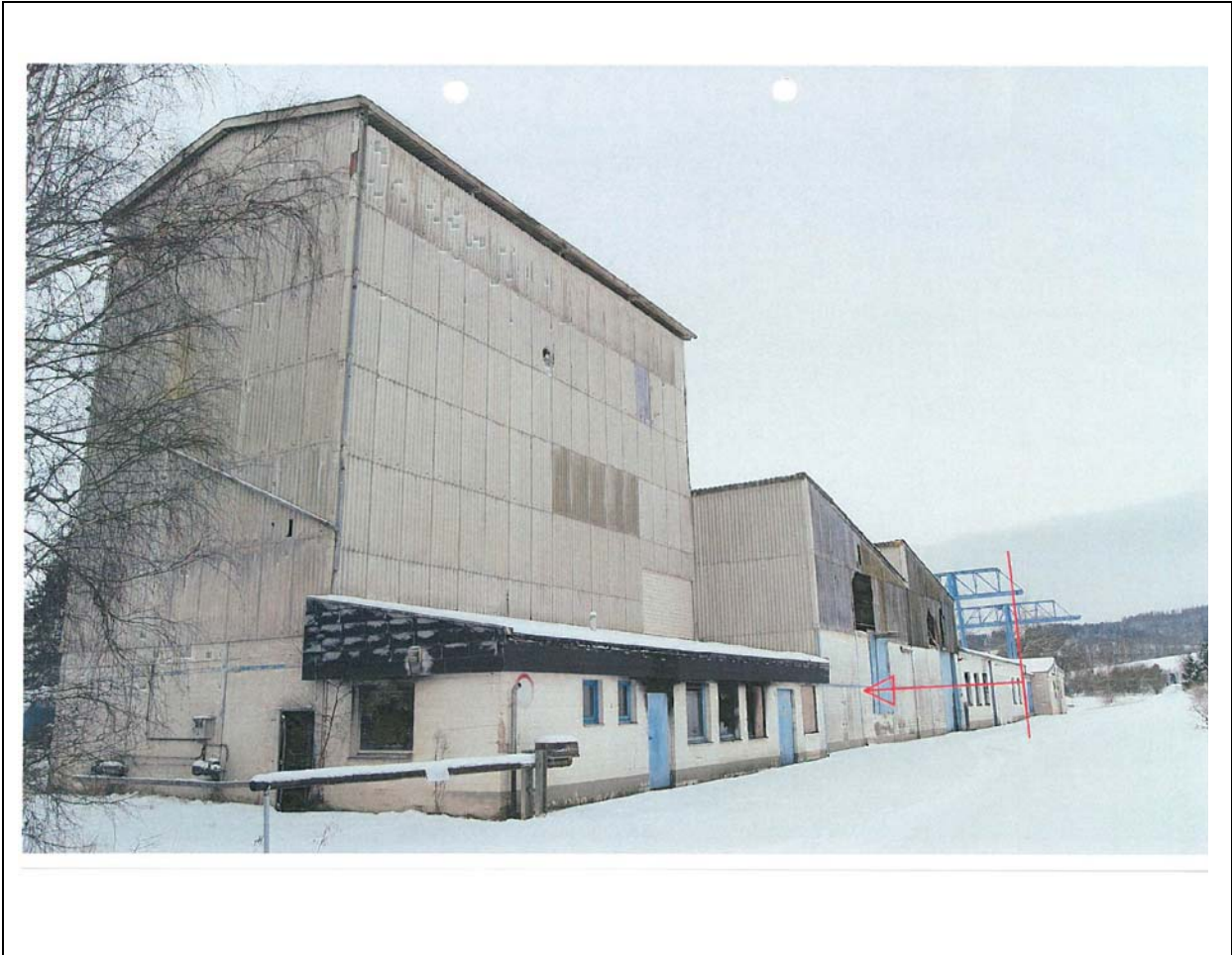
Abb. 6: Bisherige Gebäudekubaturen des ehemaligen Kalksandsteinwerkes)
