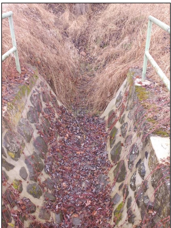
Abb. 15: Befestigte Grabenunterführung durch die Salzschlirfer Straße an der südwestlichen Grenze des Plangebietes.
